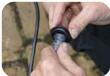
Branchez les ampoules à travers l'œillet et remplacez l'œillet.
