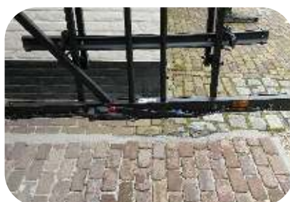
Fixez tout le câblage avec les serre-câbles fournis à l'arrière du conduit horizontal inférieur.
